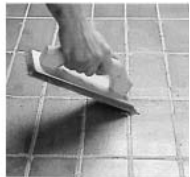
Abziehen mit Schlämmkelle.
