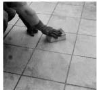
Schlämme aufnehmen mit Viskoseschwamm.
