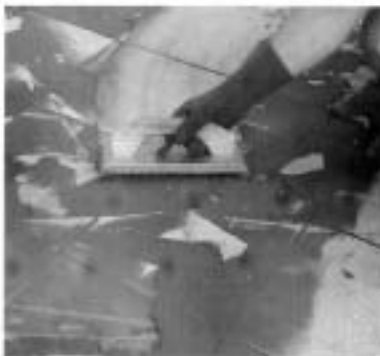
Abziehen mit Schlämmkelle.
