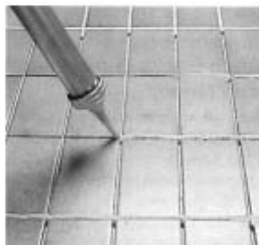
Ausspritzen der Fugen.
