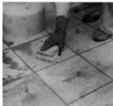
Emulgieren mit hartem Schwamm oder Handhalter mit Pad.
